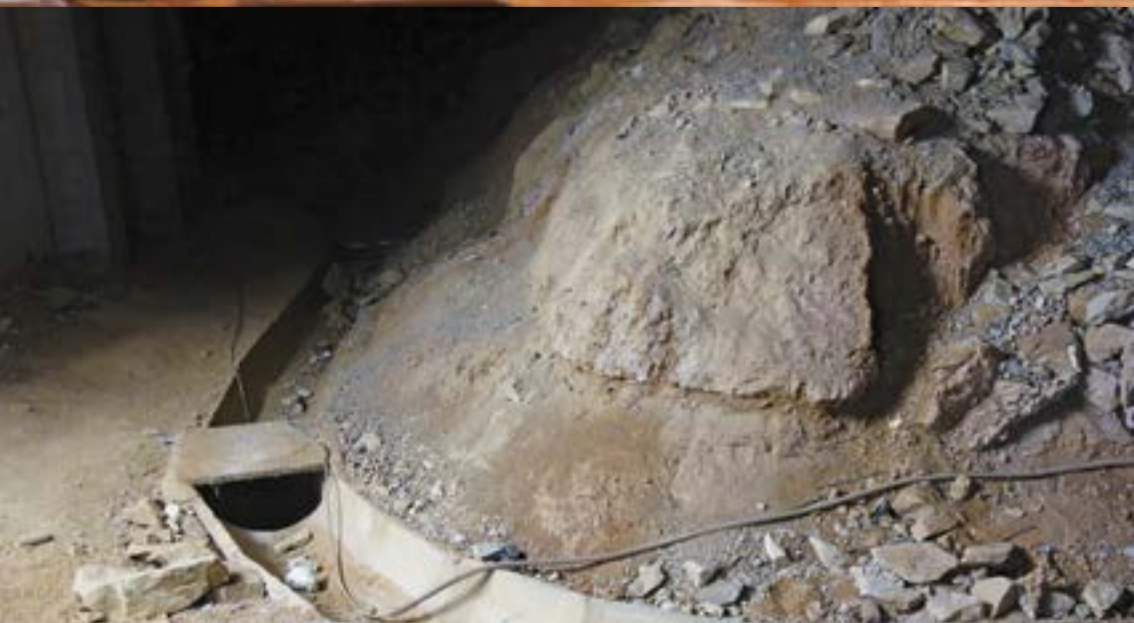
RIGOLE DE RÉCUPÉRATION D'EAU DE PLUIE, SOUS-SOL DU ZÉNITH
